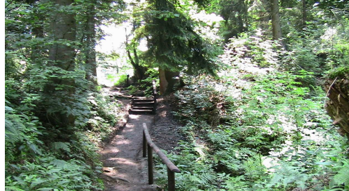
Zugang mit neuem Geländer und Stufen
